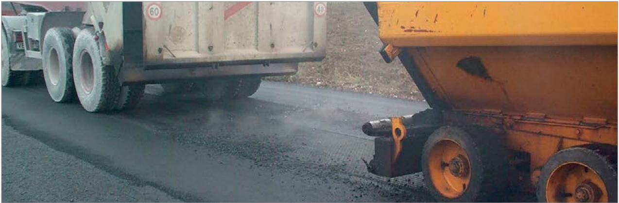
Rinforzo pavimentazione stradale con geogriglia bitumata HaTelit
