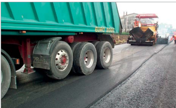
Fase di stesa del conglomerato bituminoso
