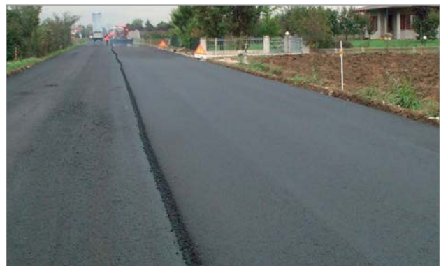
Stesa dello strato di tappeto bituminoso
